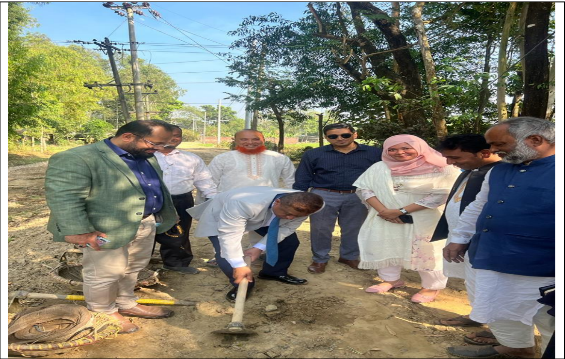
চিত্রঃ ০২ জনাব মোঃ মিজানুর রহমান, মহাপরিচালক, দুর্যোগ ব্যবস্থাপনা অধিদপ্তর, ঢাকা কর্তৃক অতিদরিদ্রদের জন্য কর্মসংস্থান কর্মসূচি (ইজিপিপি) এর আওতায় পূর্ব সাতবাড়ীয়া বাগিচাহাট হতে সাতবাড়ীয়া বরমা সংযোগ সড়ক পর্যন্ত রাস্তা সংস্কার ও মাটি ভরাট কাজ পরিদর্শন।
