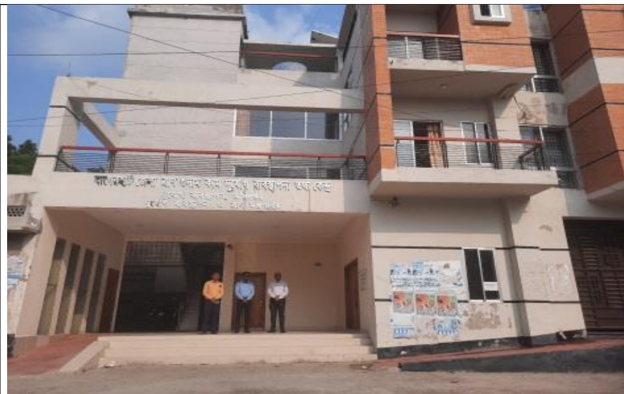
চিত্রঃ ০২ জনাব মোঃ মিজানুর রহমান, মহাপরিচালক, দুর্যোগ ব্যবস্থাপনা অধিদপ্তর, ঢাকা কর্তৃক বান্দরবান জেলা ত্রাণ গুদাম কাম দুর্যোগ ব্যবস্থাপনা তথ্য কেন্দ্র নির্মাণ প্রকল্প পরিদর্শন।
