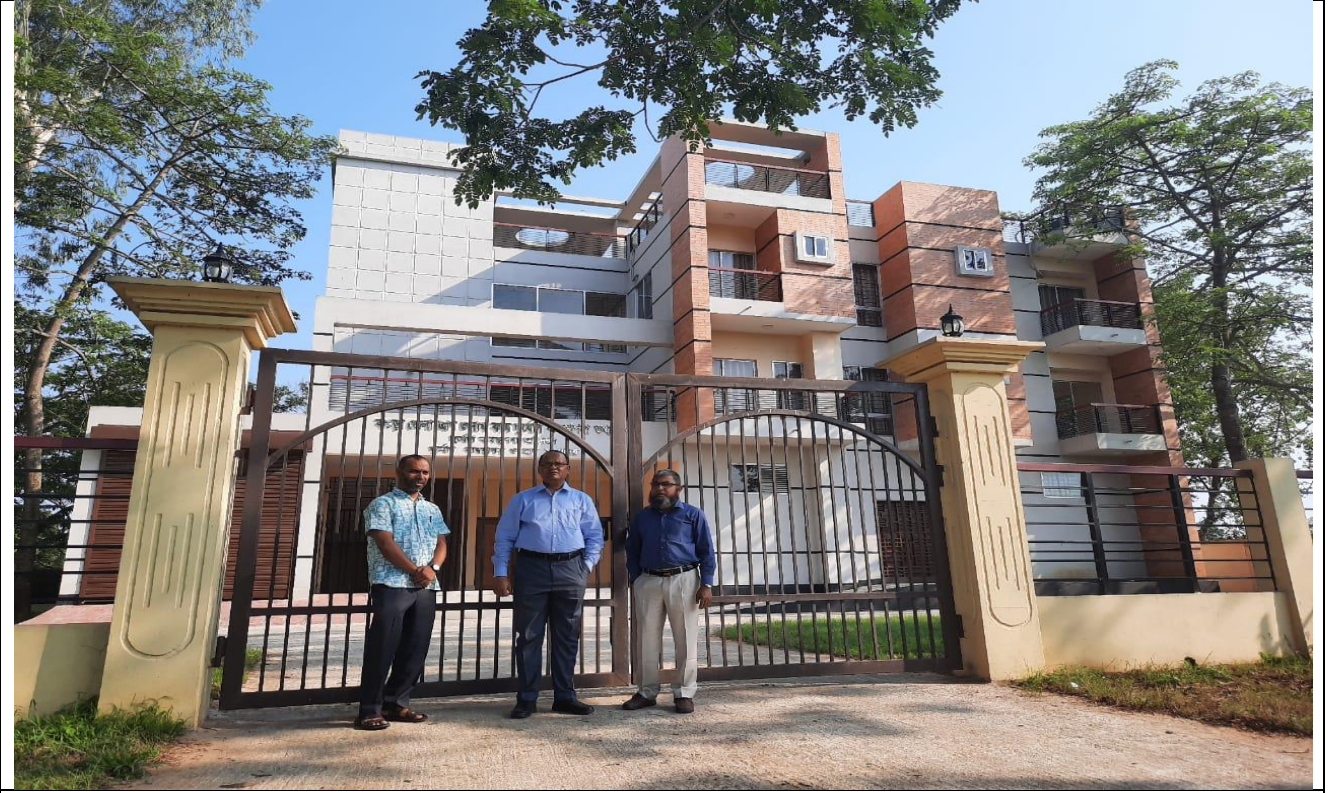
চিত্রঃ ০৪ জনাব মোঃ আব্দুল্লাহ আল-মামুন, প্রকল্প পরিচালক, দুর্যোগ ব্যবস্থাপনা অধিদপ্তর, ঢাকা কর্তৃক বাগেরহাট জেলা ত্রাণ গুদাম কাম দুর্যোগ ব্যবস্থাপনা তথ্য কেন্দ্র নির্মাণ প্রকল্প পরিদর্শন।
