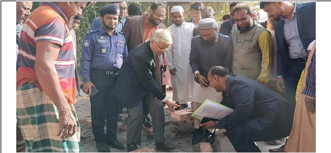
চিত্রঃ ০২ ড. শামসুল আলম, প্রতিমন্ত্রী, পরিকল্পনা মন্ত্রণালয় কর্তৃক চাঁদপুর জেলার মতলব উত্তর উপজেলার গ্রামীণ মাটির রাস্তা এইচবিবি করণের নিমিত্ত কাজের শুভ উদ্বোধন।
