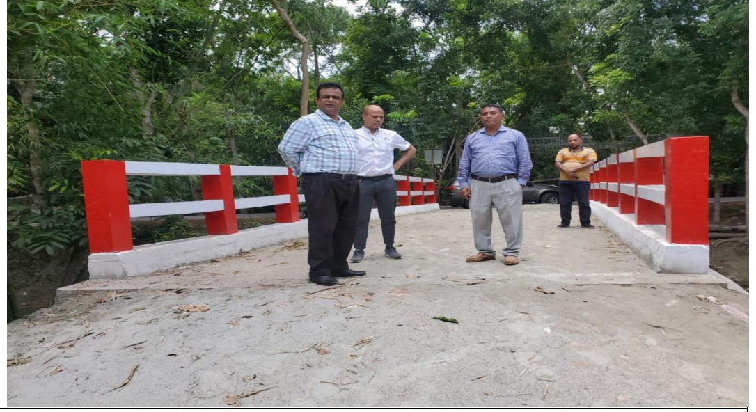
চিত্রঃ ০৪ জনাব মোঃ ইসমাইল হোসনে, উপপ্রকল্প পরিচালক, সেতু/কালভার্ট প্রকল্প, দুর্যোগ ব্যবস্থাপনা অধিদপ্তর কর্তৃক মাদারীপুর জেলার সদর উপজেলায় নির্মিত সেতু পরিদর্শন।
