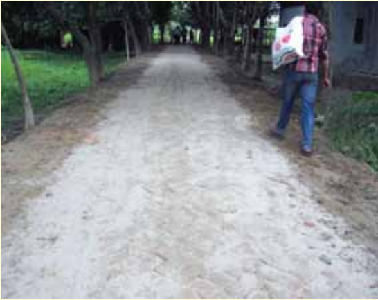
গ্রামীণ অবকাঠামো সংস্কার (কাবিটা) প্রকল্পের আওতায় রাস্তা সংস্কার, অষ্টধার, ময়মনসিংহ সদর
